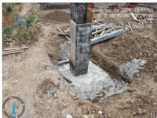
FOTO 03: SAPATAS CONCRETADAS;
