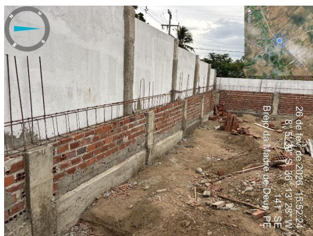
FOTO 05: VIGA BALDRAME E PILARES;
