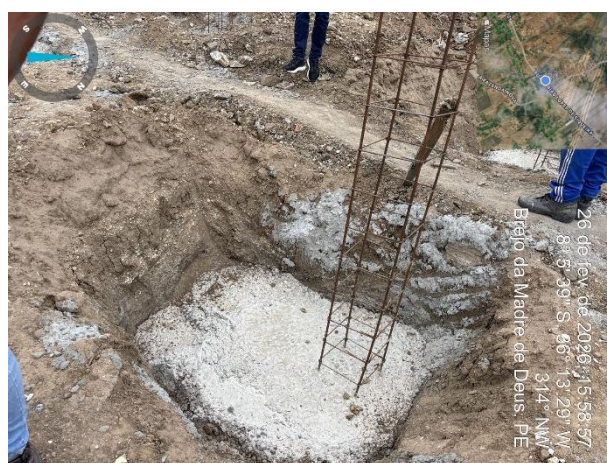
FOTO 02: SAPATAS CONCRETADAS;
