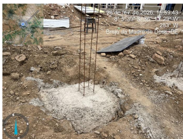
FOTO 01: SAPATAS CONCRETADAS;
