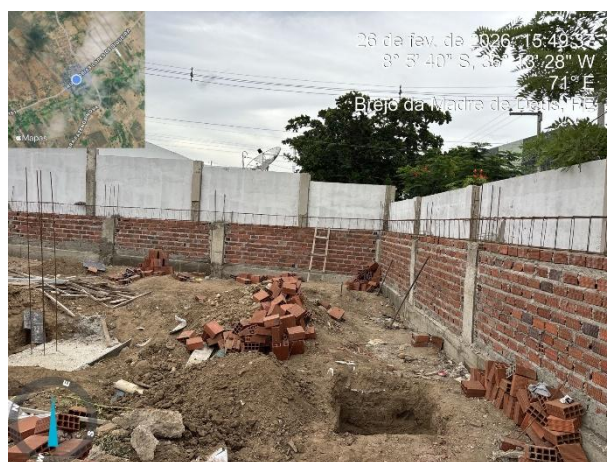
FOTO 06: VIGA BALDRAME E PILARES;
