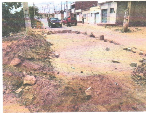
FOTO 06: RUA DA SUBESTAÇÃO;
