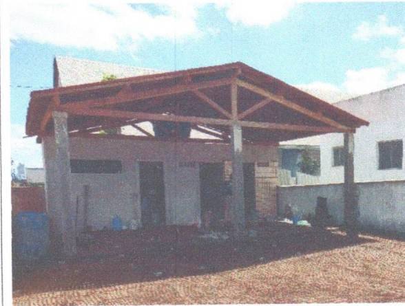
FOTO 6: Tesouras, Trama e telhamento da coberta
