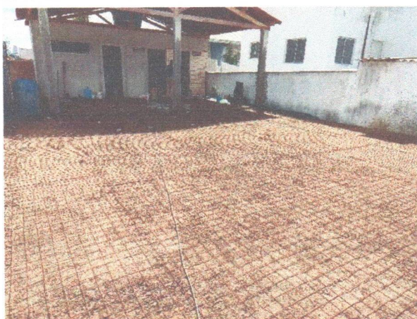
FOTO 7: Aterro Concluído e compactado e malha;
