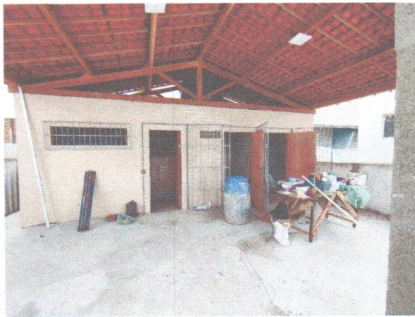
FOTO 16: Coberta, Luminárias, Esquadrias e Revestimento;
