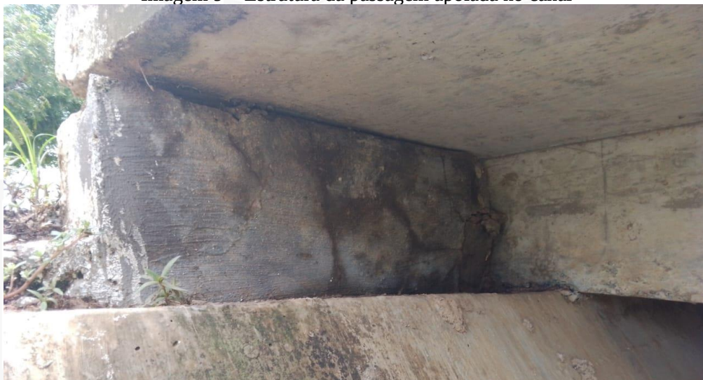
Imagem 9 – Estrutura da passagem apoiada no canal
